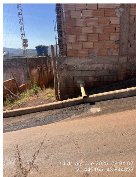
Foto 38 Escoamento de efluente doméstico Autor: CLAM, 2025.
